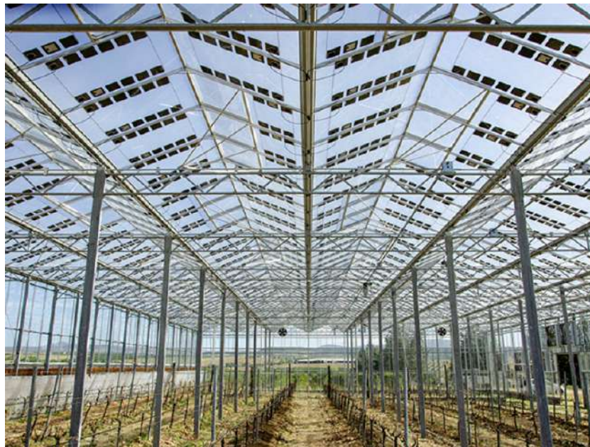
Figura 4: Hivernacle amb cel·les fotovoltaïques incorporades al vidre, de SolarInfo.es [9]
